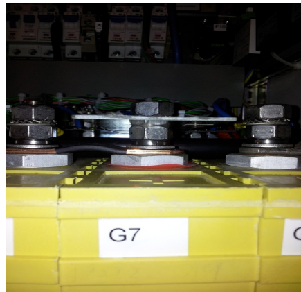
Abbildung 2a: Beispiel Montage mit Gewindestange
